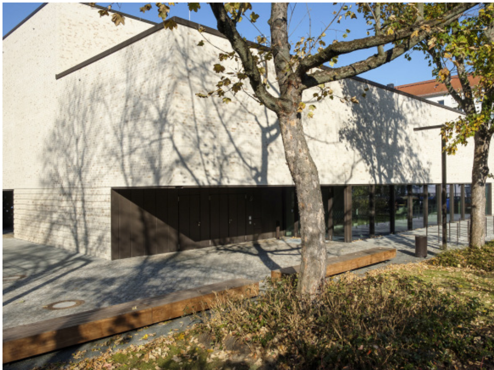
Konzeption und Planung einer Schulsporthalle für das Berufliche Schulzentrum Gastgewerbe „Ernst Lößnitzner“.
