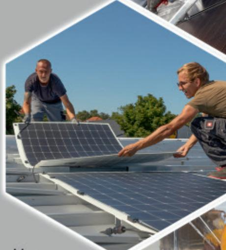
**Wir sind spezialisiert auf die Installation von Leichtbaumodulen auf Dächern mit geringen Dachlastreserven.**
